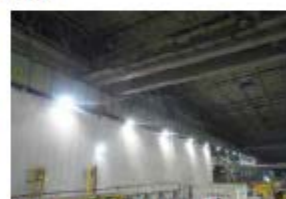
■Pic.6 工場照明のLED化
