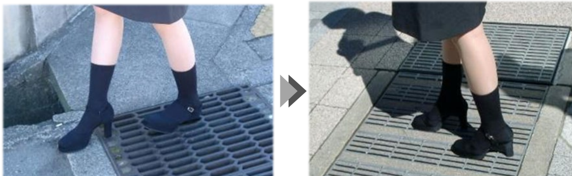
図 19 グレーチングの交換
