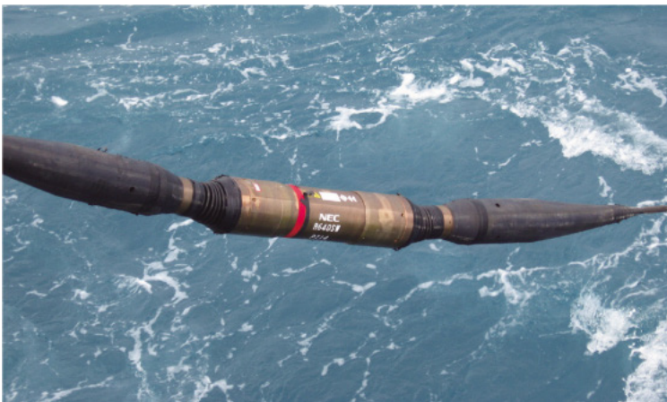
東南アジア沖海域に敷設されるNECの光海底ケーブルシステム 提供：NEC
