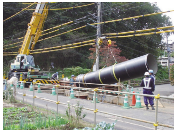
計画的な水道管工事
