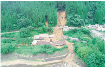
2020年7月豪雨におけるドローンを活用した被害状況調査（大分県日田市中津江村）
