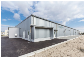
施工事例：システム建築(倉庫)
