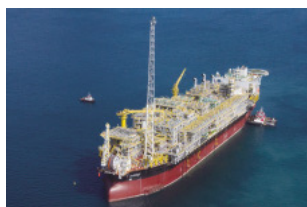
ブラジル沖で稼働中のFPSO (Floating Production, Storage and Offloading system: 浮体式海洋石油・ガス生産貯蔵積出設備)
