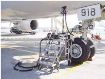
航空機用動力設備による航空機への電源供給
