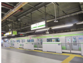
山手線品川駅 ホームドア設置工事
