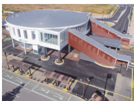
内房線袖ヶ浦駅 橋上化工事
