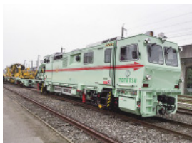
世界初の 新幹線レール交換システム
