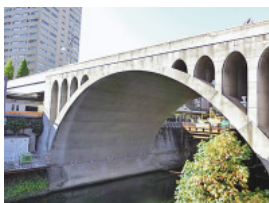
聖橋 長寿命化工事
