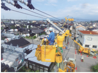
電力供給設備
