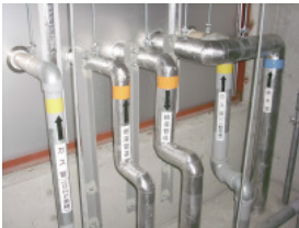
給水、給湯、ガスなどの屋内配管
