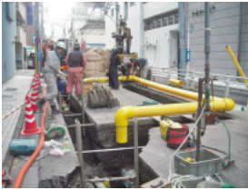
土中埋設前のガス導管(黄色の管がガス管)
