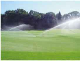
ゴルフ場におけるイリゲーション工事(散水設備)
