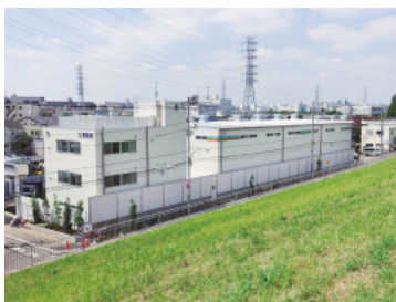
2017年10月に稼働を開始した板橋リサイクルセンター
