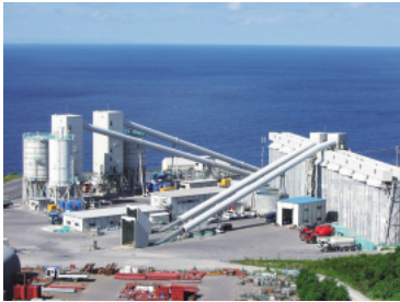
島根原子力発電所3号機建設工事 コンクリート製造設備
