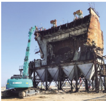
プラント解体工事
