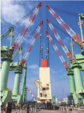
ブロック生産現場風景
