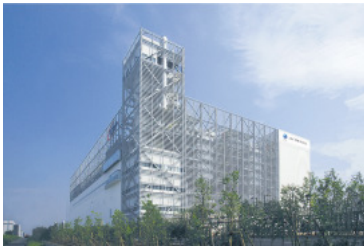
当社最大の処理・発電能力を持つ 東京臨海エコクリーン (旧東京臨海リサイクルパワー)
