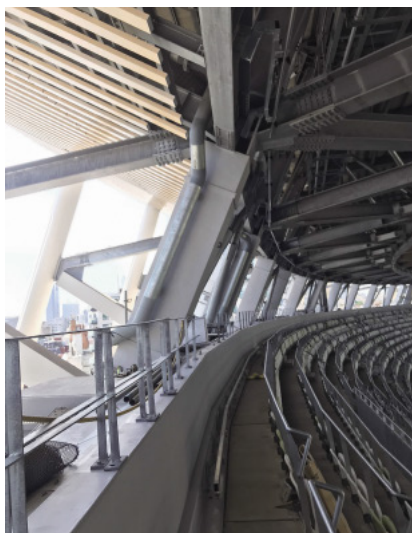
競技場の雨水配管
