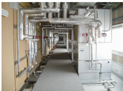
データセンターの空調配管
