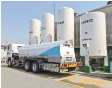
充填工場の貯蔵用液化低温タンク
