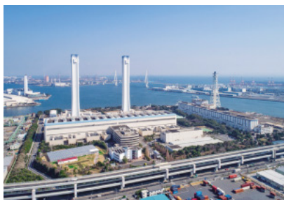
横浜火力発電所
