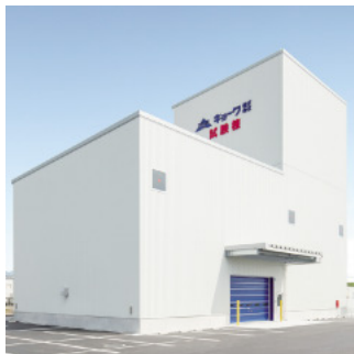
北陸総合センター試験棟
