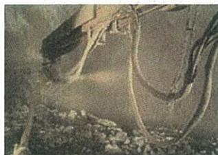
トンネル工事で使用される吹付けコンクリートの使用材料の一部をフライアッシュに置き換えることで、吹付け時の跳ね返り量の低減による使用材料の節約や、粉じん量の低減により作業環境が改善されます。
