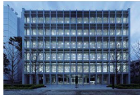
生まれ変わった外壁タイルを 活用した研修センター
