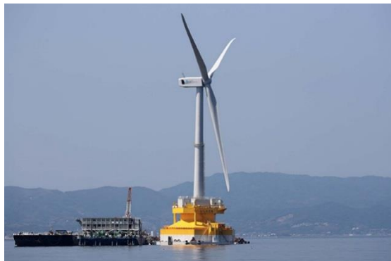
写真 2 5MW 浮体式洋上風力発電設備「ふくしま浜風」
