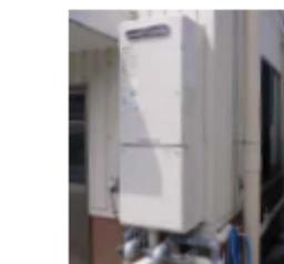
Fig.16 高効率ガス給湯器
