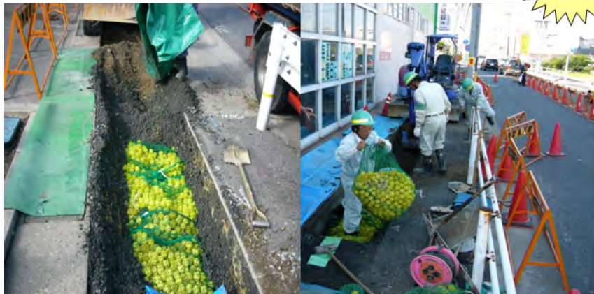
ECOボール 直径5cm ポリプロピレン製
