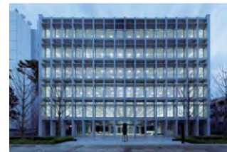
生まれ変わった外壁 タイルを活用したビル
