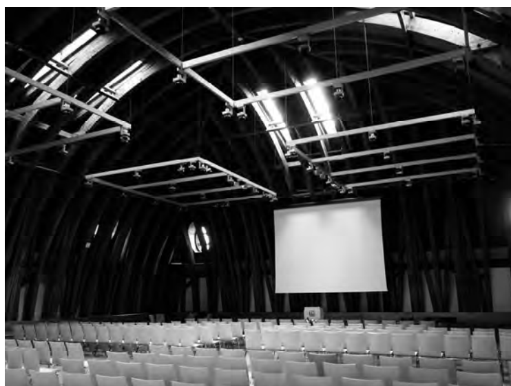
図5 ウィーン工科大学本館最上階の木造屋根内部のリノベーション
