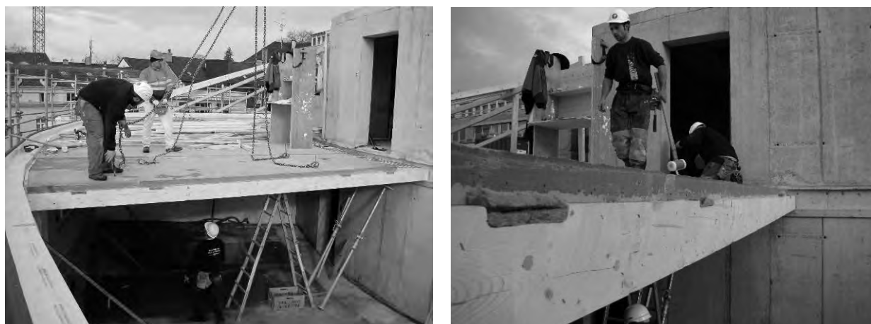
図表 4－8 コンクリートと CLT の複合床パネルの施工例
