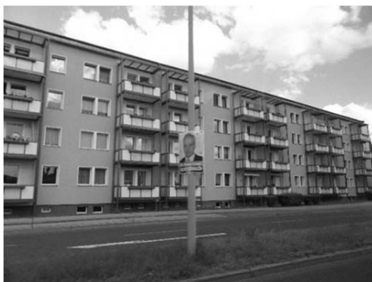
改装後：5階を4階建てに減築しバルコニー設置
