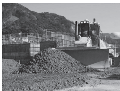
自動ブルドーザ: まき出し作業の自動化
