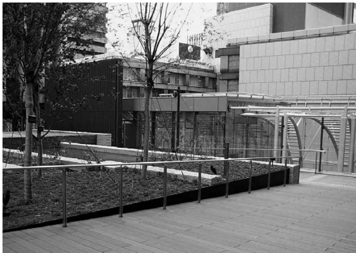
経団連会館4階スカイガーデン(デッキ部分にWPRCを採用)
