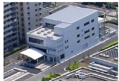
↑ Smart Station実験棟 JR東日本研究開発センター ファミリーデー11/3(祝)開催
