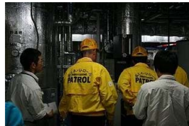
信州省エネパトロール隊 (長野県ホームページより)
