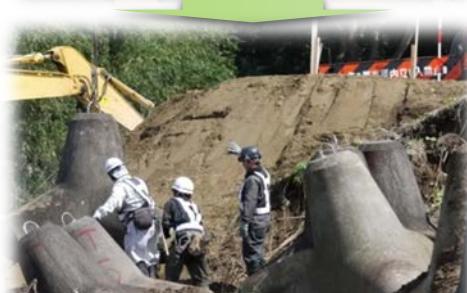
翌日より応急復旧工事開始
