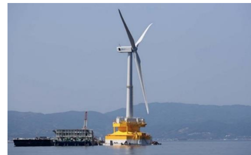
写真2 5MW浮体式洋上風力発電設備「ふくしま浜風」
