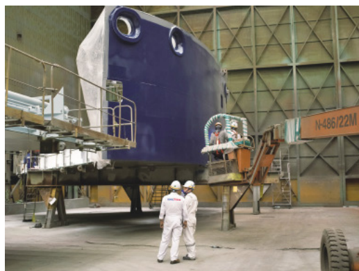
ヤマルLNGプロジェクト向け砕氷LNG船建造の様子 copyright Charles XELOT
