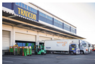
トランコム自社センターである小牧ロジスティクスセンター
