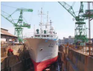
ドックでの船舶修繕
