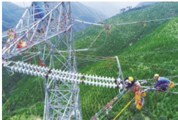
送電線建設現場での緊線作業
