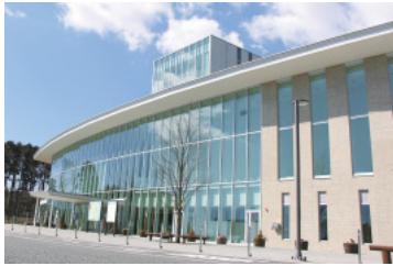
竣工した多目的ホール
