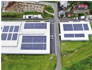
オンサイト自家消費型太陽光発電(工場施設への導入事例)
