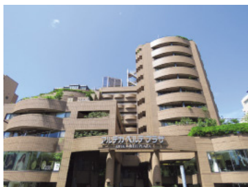
高級マンション「ベルテ南青山」。日本でも有数の高級住宅街に立地する最高級邸宅
