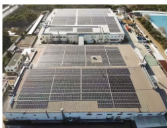
上海工場に設置したソーラーパネル
