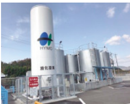
新設の原料貯槽（山口工場）
