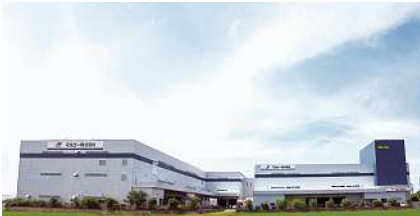
新潟共配センター全景
