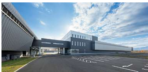
2011年11月 石狩データセンター開所：消費電力削減に取り組み、脱炭素と持続可能な社会づくりに貢献
