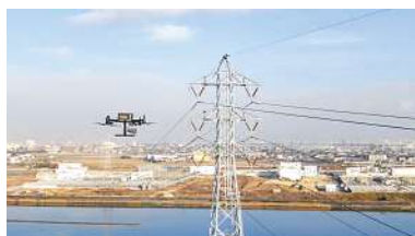
鉄塔や送電線の点検にドローンを活用
