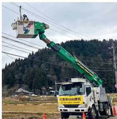
復旧工具の仕様を全国で統一し、迅速な災害復旧応援を実現(令和6年能登半島地震の復旧対応の様子)
