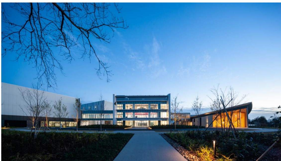
茨城県取手市に誕生した日本初の総合イノベーションプラットフォーム ICI総合センター。大規模な実証実験施設を兼ね備えており、共創するパートナーとさまざまな社会課題解決に取り組む。
