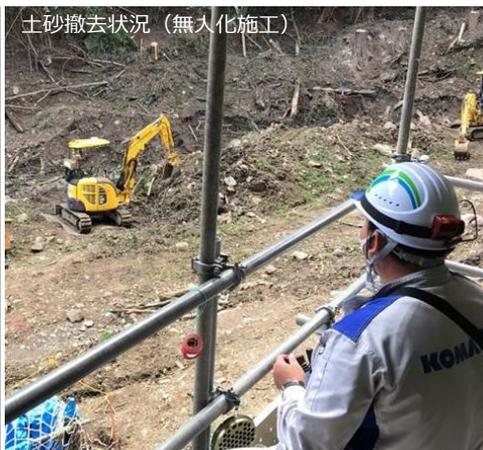
土砂撤去状況（無人化施工）
