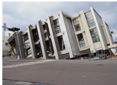
能登半島地震により倒壊したビル
