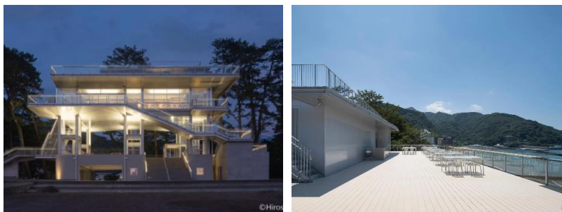
伊豆市 松原公園津波避難複合施設「テラス オレンジ トイ」
