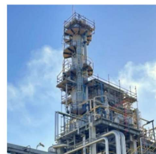
油化プラント外観
