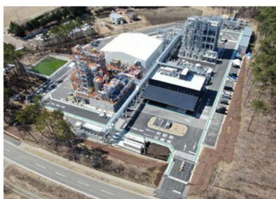
BR エタノール実証プラント [積水化学]
