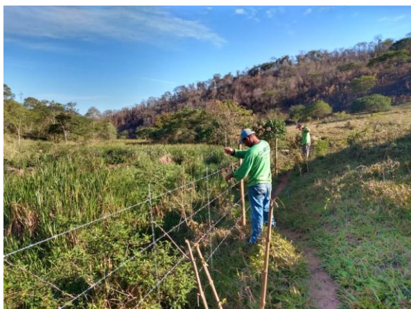
フェンス設置の様子
