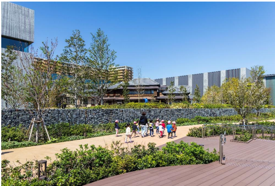
NOVARE(清水建設)
