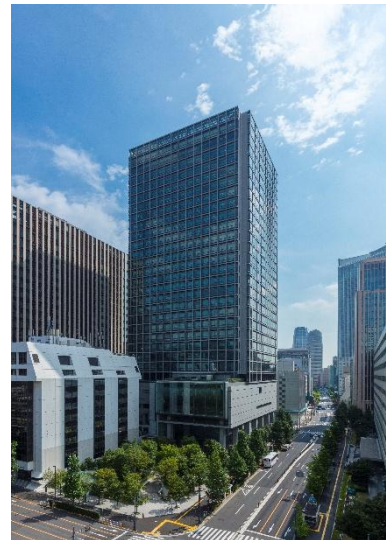
飯野ビル外観
