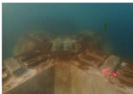
図 1. 藻礁ブロックの設置状況
